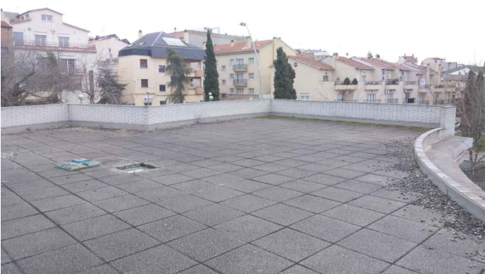
Vista coberta plana amb sistema de llosa filtrant
