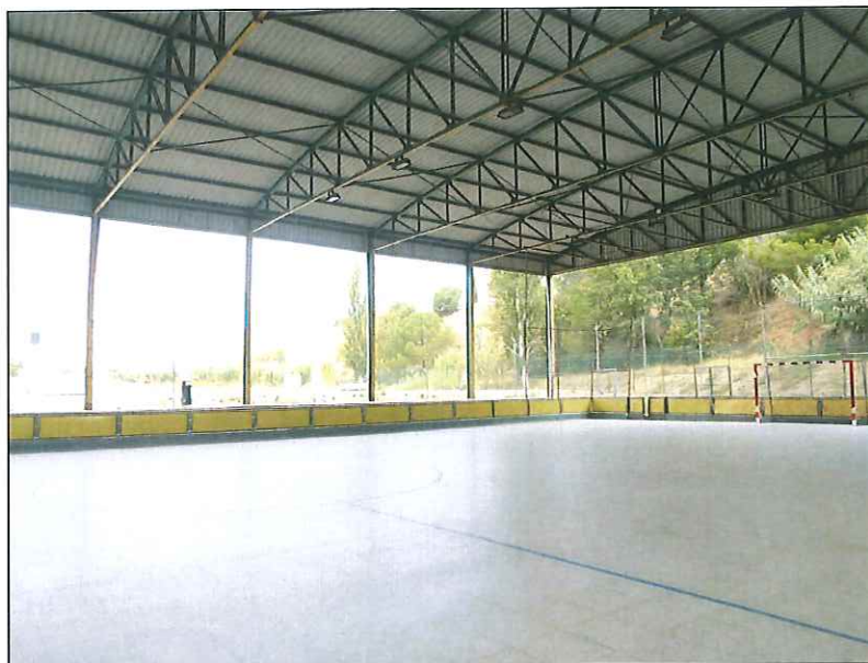
Vista 5 - Vista interior de la cantonada façana nord-oest i nord-est.
