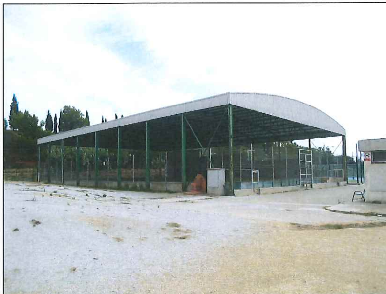
Vista 1 - Façana nord-oest i sud-oest
