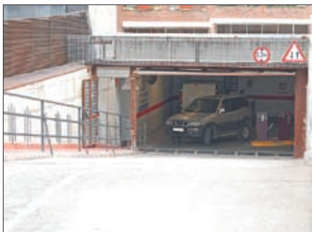
NOVA BARANA D'ACCÉS PER A VIANANTS
